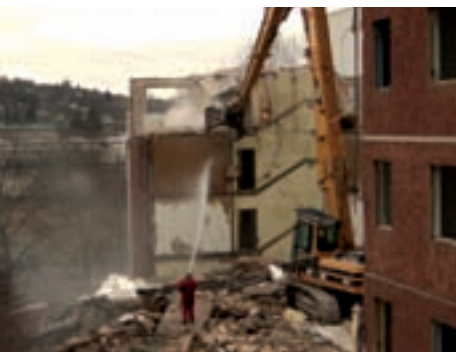
Abbruch in der Stregdaer Allee 45–48
