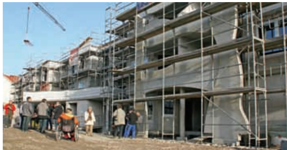
Aussenansicht des Rohbaus
