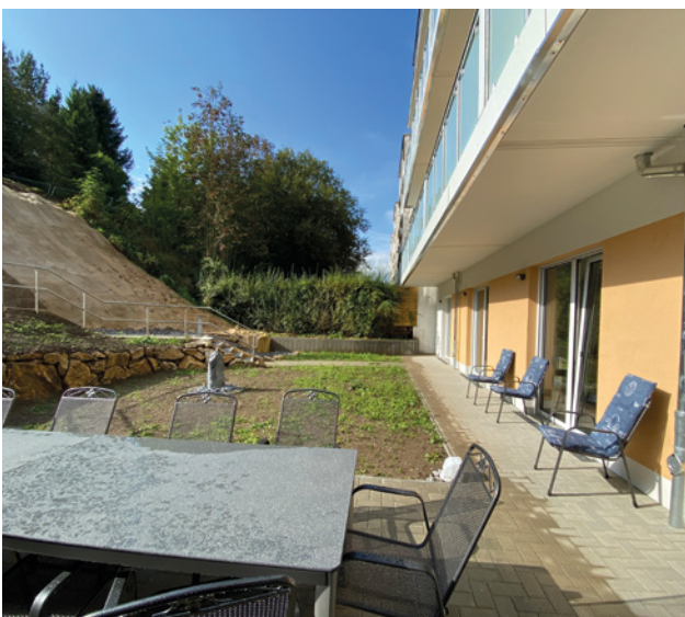
Die Aussenanlagen sind fertiggestellt
