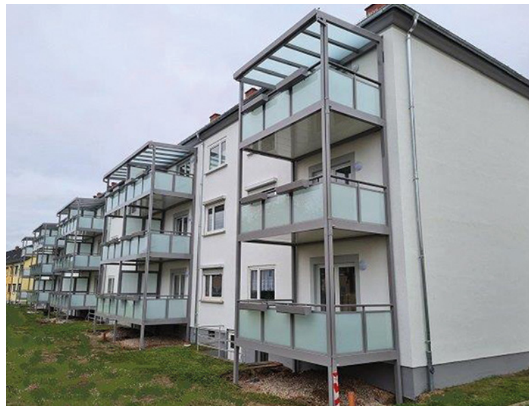
Neue Balkone in der Herbsleber Straße 29 – 35
